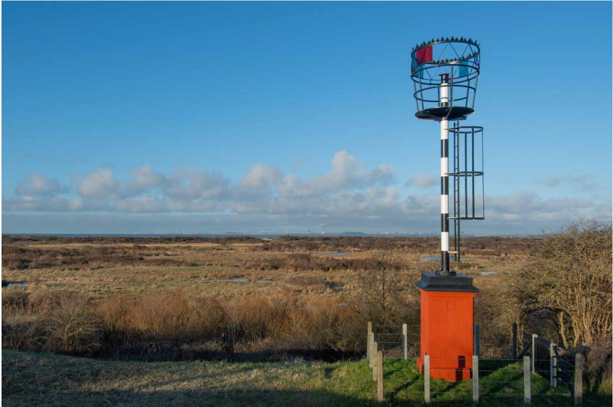
Foto gerenoveerd lichie, Jan Baks
